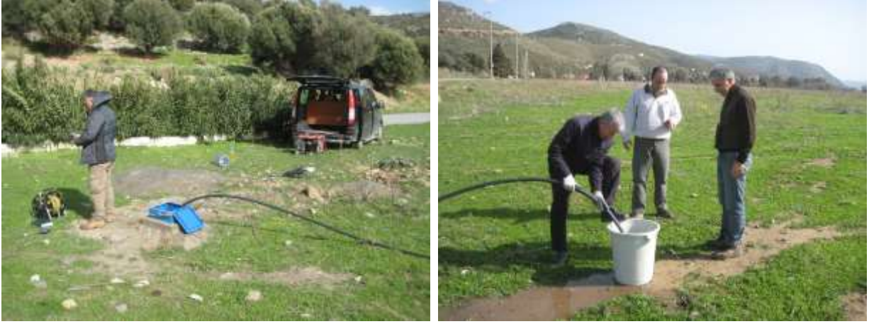
Şekil 3.2. Kuyuların pompa ile geliştirilmesi
