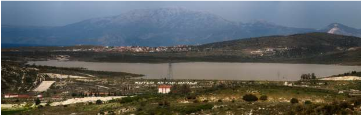
Şekil 7.3. Kutlu Aktaş Barajı'ndan görünüm
