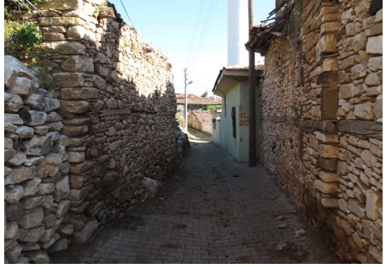
Resim 7. Yerleşimin dış çeperindeki yollarda görülen kilit-taş kaplama (Eken Güney, 2017)
