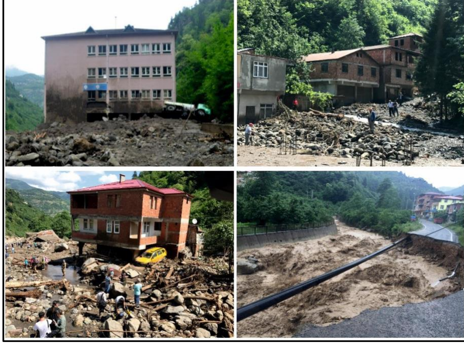
Şekil 11. Çamlıktepe sel-taşkınından görünüşler (AFAD, 2019)
